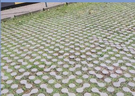
Abbruch einer vollversiegelten bzw. Neubau einer Verkehrsfläche mit offenen wasserdurchlässigen Betonsteinpflasterbelag. Die Fugen sind gefüllt mit einer Substratmischung zur Ansaat von Rasen oder Sedum-Mischungen. Das Substrat ist ebenfalls wasserdurchlässig und reinigt als Bodenschicht das Niederschlagswasser.
