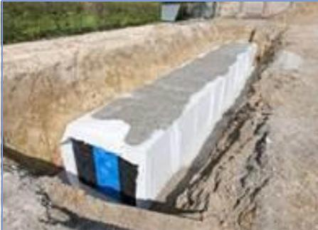
Die Rigole ist eine unterirdische Versickerungsart. Aufgrund der unterirdischen Zuführung des Wassers erfolgt keine Reinigung durch eine Oberbodenpassage. Rigolen können in Verbindung mit einer gedrosselten Ableitung auch bei schlechten durchlässigen Böden eingesetzt werden. Der Rigolenkörper wird meist aus Kies (16/32 mm) hergestellt. Alternativ können auch Kunststofffüllkörper verwendet werden, die sich durch ein Porenvolumen von über 90% auszeichnen. Die Bemessung erfolgt nach DWA A138.
